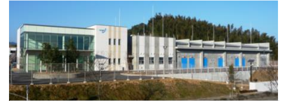
水素エネルギー製品研究試験センター
